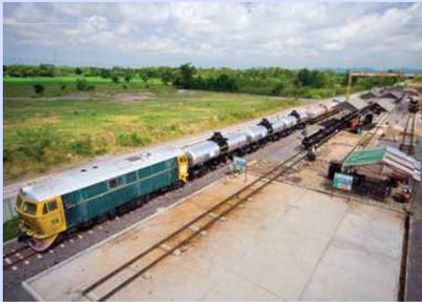
งานซ่อมบำรุงถังบรรจุน้ำมันรถไฟ
