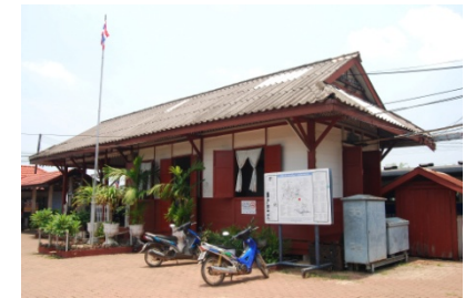
ภาพที่ 5 อาคารสถานีรถไฟกบินทร์บุรี อ.กบินทร์บุรี จ.ปราจีนบุรี
