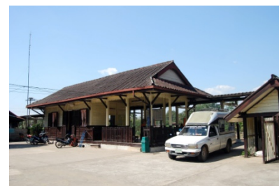
ภาพที่ 38 อาคารสถานีรถไฟเมืองพล อ.พล จ.ขอนแก่น
