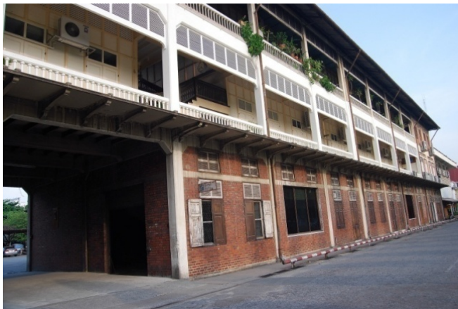
ภาพที่ 111 อาคารที่ทำการพัสดุฯ
