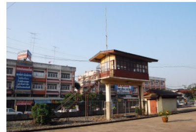
ภาพที่ 85 หอสัญญาณประแจกล ย่านสถานีรถไฟนครปฐม อ.เมือง จ.นครปฐม
