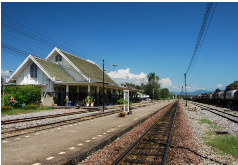
ภาพที่ 58 อาคารสถานีรถไฟศิลาอาสน์ อ.เมือง จ.อุดรดิตถ์
