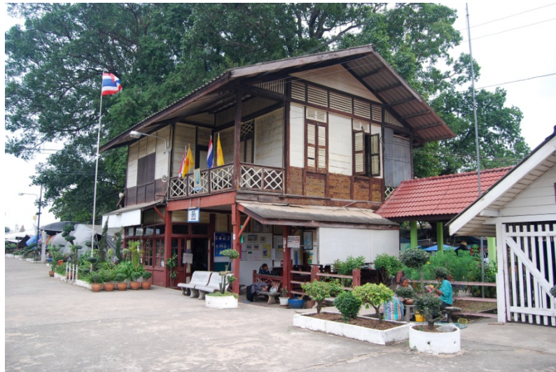
ภาพที่ 91 อาคารสถานีนรไฟสีคิ้วหลังเก่า อ.สีคิ้ว จ.นครราชสีมา
