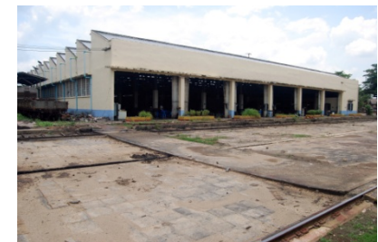
ภาพที่ 88 อาคารโรงรถจักร ย่านสถานีรถไฟชุมทางทุ่งสง อ.ทุ่งสง จ.นครศรีธรรมราช
