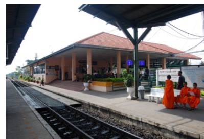
ภาพที่ 22 อาคารสถานีนีรลไฟชุมทางฉะเชิงเทรา อ.เมือง จ.ฉะเชิงเทรา
