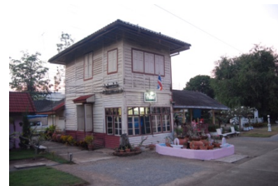
ภาพที่ 79 อาคารสถานีรถไฟบ้านใหม่ อ.เมือง จ.พิษณุโลก
