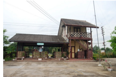
ภาพที่ 41 อาคารสถานีรถไฟภูตจิก อ.สูงเนิน จ.นครราชสีมา
