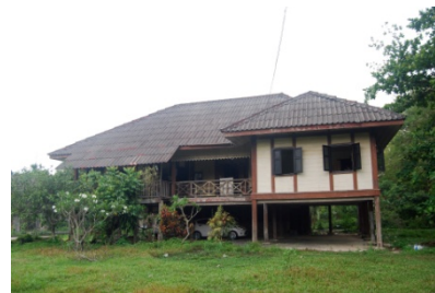
ภาพที่ 84 บ้านพักพนักงานรถไฟ ย่านสถานีรถไฟชุมทางทุ่งสง อ.ทุ่งสง จ.นครศรีธรรมราช
