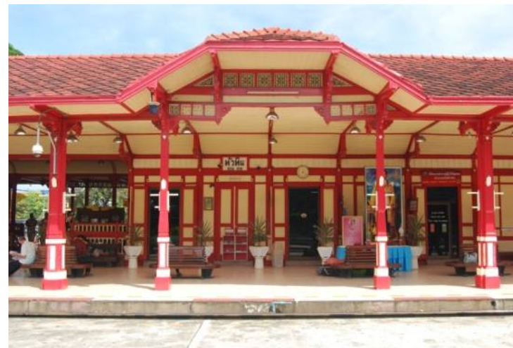
ภาพที่ 97 อาคารสถานีนีรลไฟหัวหิน
