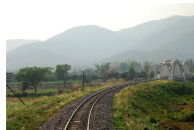
ภาพที่ 89 สะพานทามภู อ.แม่ทา จ.ลำพูน
