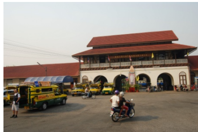
ภาพที่ 2 อาคารสถานีรถไฟนครลำปาง อ.เมือง จ.ลำปาง
