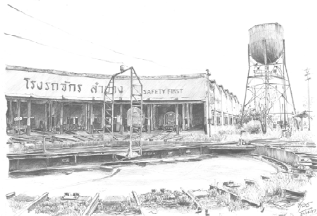
ภาพที่ 152 โรงรถจักรลำปาง ย่านสถานีรถไฟนครลำปาง อ.เมือง จ.ลำปาง (ภาพโดย ปรุพท์ เทพรัตน์)
