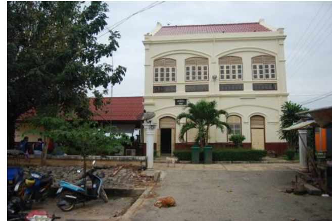
ภาพที่ 107 อาคารสถานีนรลไฟพิจิตร
