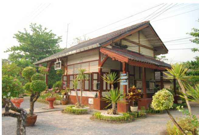
ภาพที่ 103 อาคารสถานีรถไฟห้วยฉัตร
